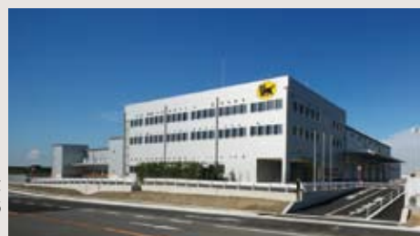
ヤマト運輸 和歌山主管支店 3階建ての事務棟と2階建ての荷さばき所・倉庫棟からなり、大型車30台、4トン車6台の着車バースがある。
