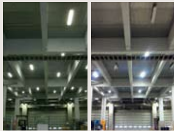
高効率反射板の取り付け前(左)、取り付け後(右) (新習志野クイック通販口ジセンター)
